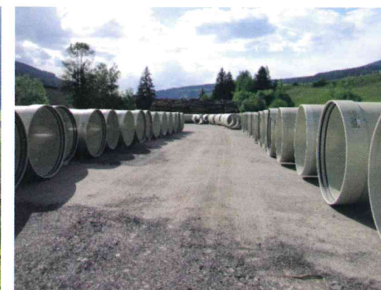
Posizionamento dei tubi in PRV all'interno di un'area messa a disposizione dal Comune di Monguelfo
